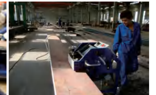
客户现场 Customer site
