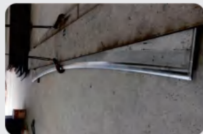
加工圆弧坡口 Process arc
